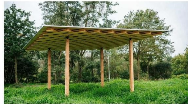
Een model van een halte voor de tram. Op de houten luifel komen geïntegreerde zonnepanelen. FOTO BOUWME
