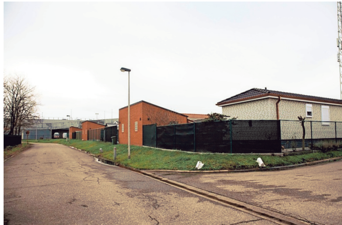
Ook aan de Oude Spoorbaan in Kuringen-Noord komen er straks nieuwe rioleringen. Foto Karolien Coenen
