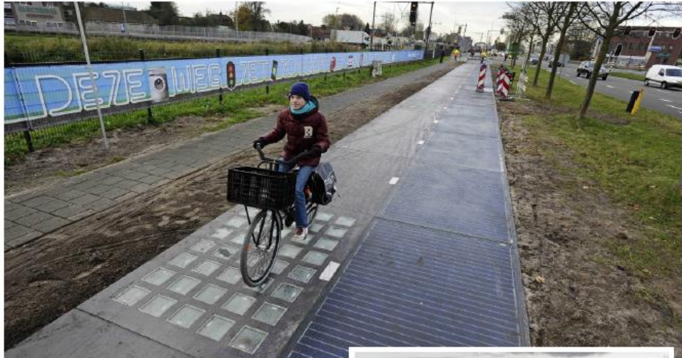
Het fietspad SolaRoad in Nederland (boven) en autoweg Wattway in Frankrijk (inzet) experimenteren al met zonnepanelen in het wegdek. Foto EPA
