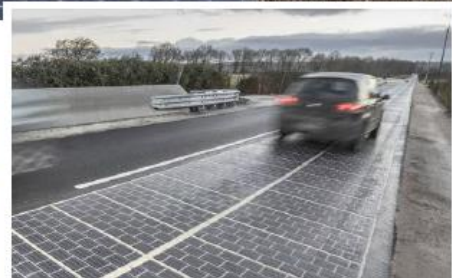
Het fietspad SolaRoad in Nederland (boven) en autoweg Wattway in Frankrijk (inzet) experimenteren al met zonnepanelen in het wegdek. Foto EPA
