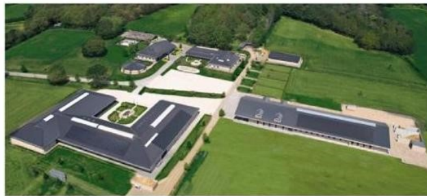
De Equitom-site, met rechts het nieuwe gebouw. FOTO RR
