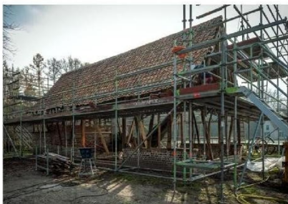
In Bokrijk loopt de restauratie van 120 gebouwen op zijn einde.
